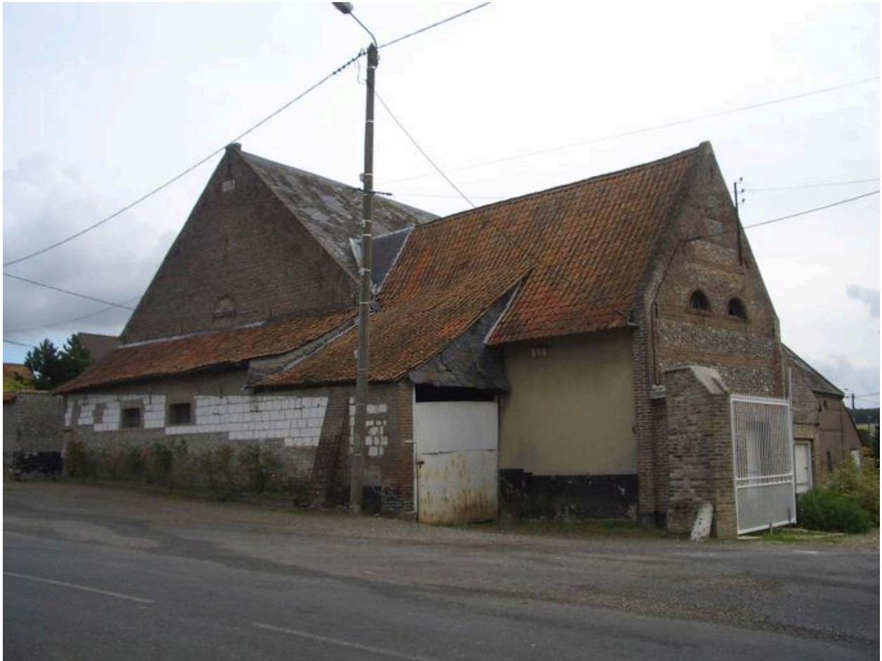
Vue des ateliers situés au nord du logis depuis la rue.
