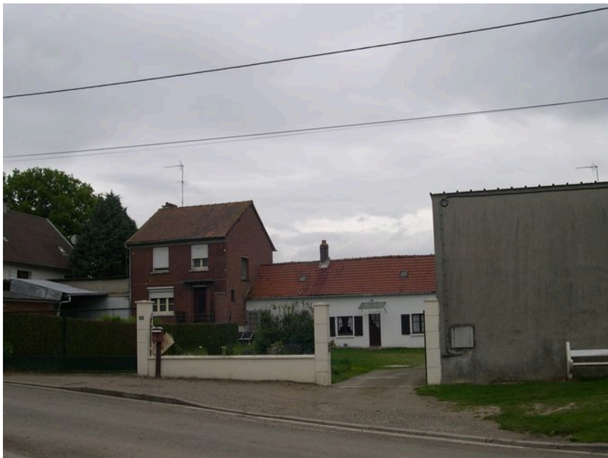
Maisons, 10 rue du Petit-Cagny.
