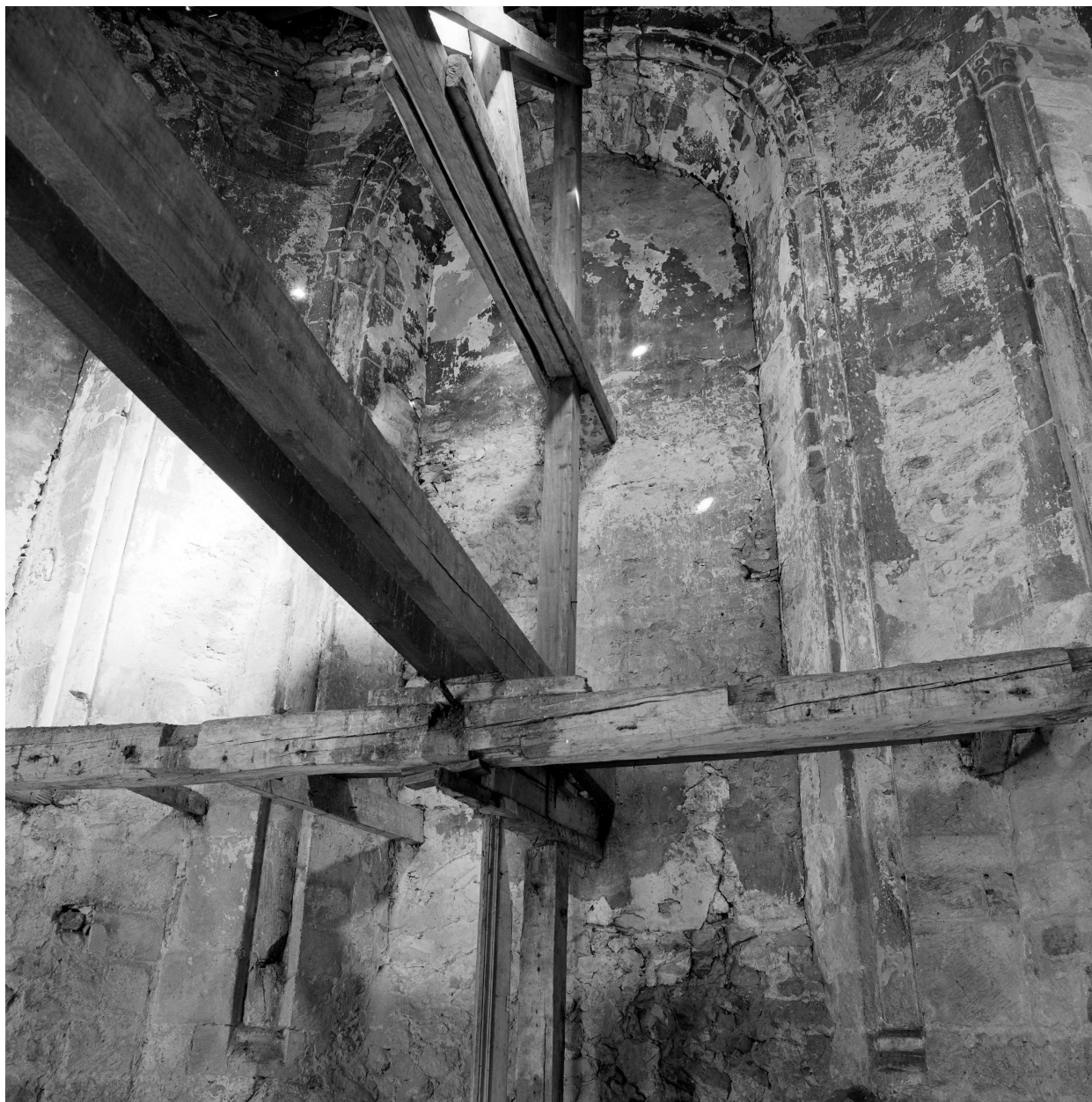
Bâtiment dans la cour, entrée 5 rue Henry, abside, pan est (vue générale).
