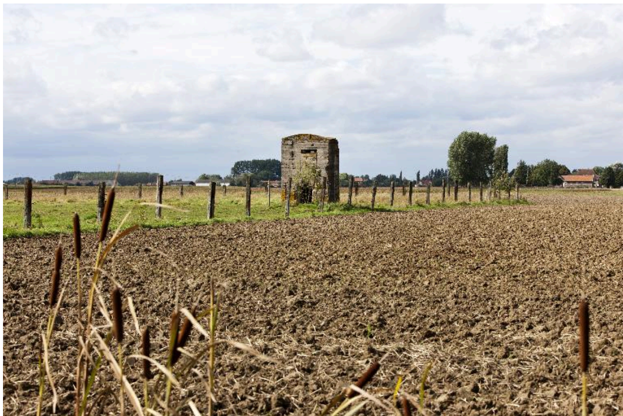
Vue générale vers le nord-ouest
