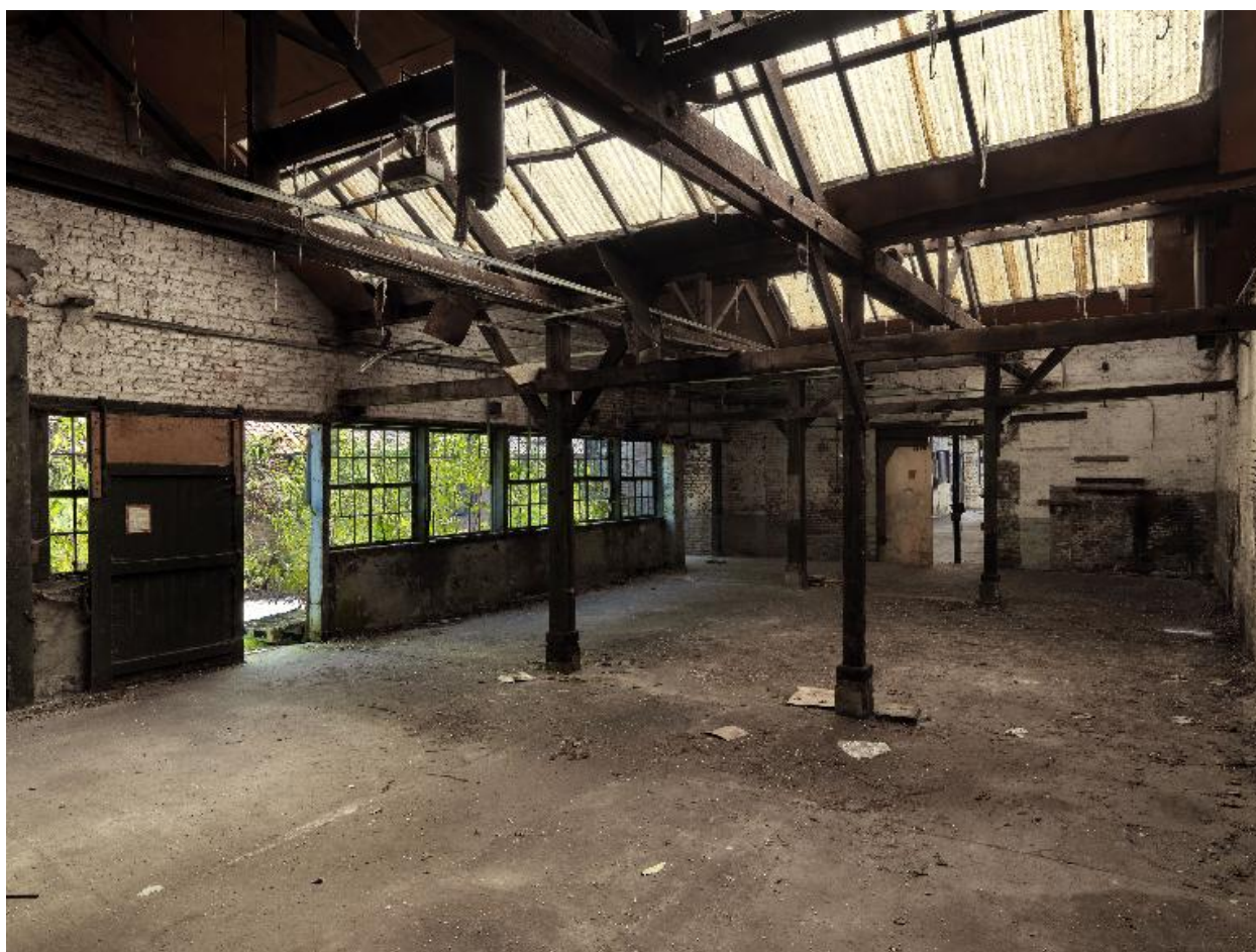
Ancien atelier de fabrication secondaire.
