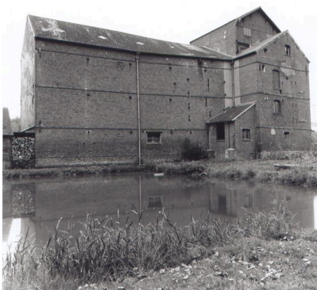
Vue d'ensemble de la minoterie.
