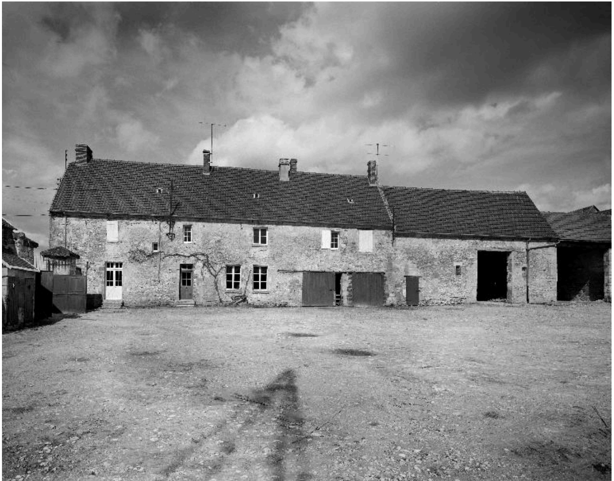
Élévation sur cour du logis et des étables attenantes.
