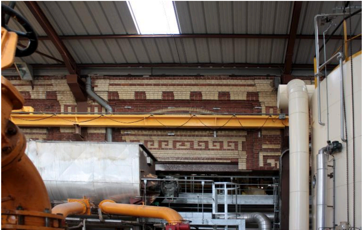
Vue partielle de l'ornementation en brique de l'ancien atelier de fabrication de la sucrierie.
