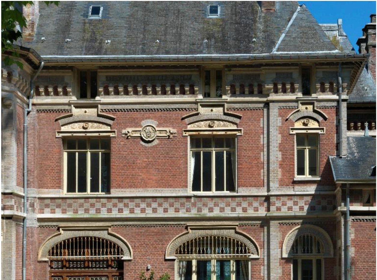
Détail de la façade postérieure.
