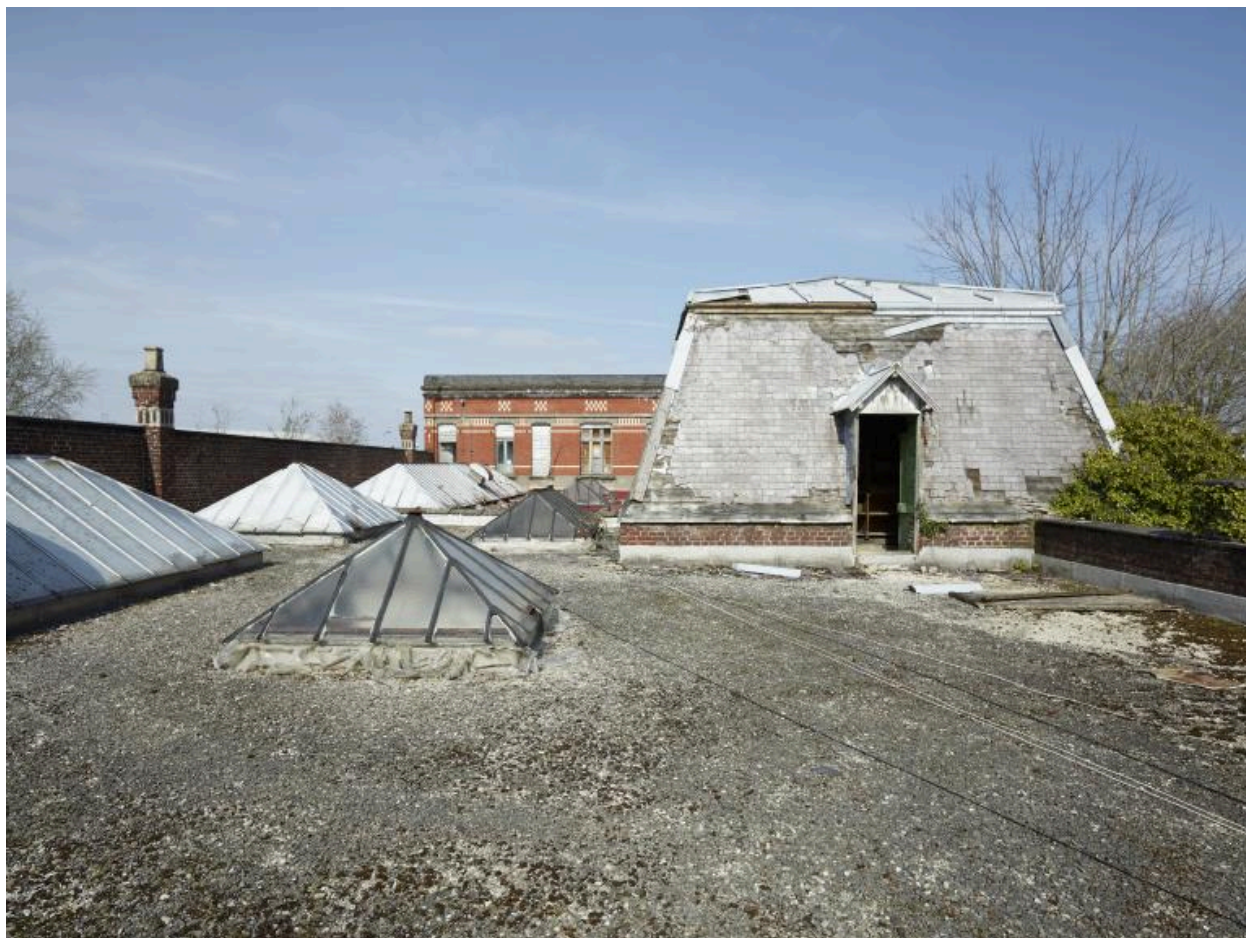
Bureaux. Couvrement. Vue prise vers l'est.
