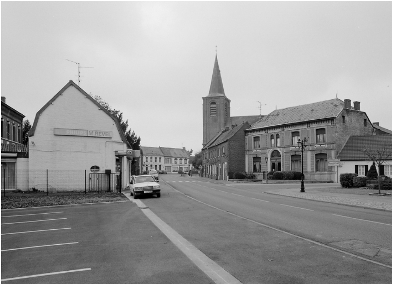
Vue générale vers l'église.
