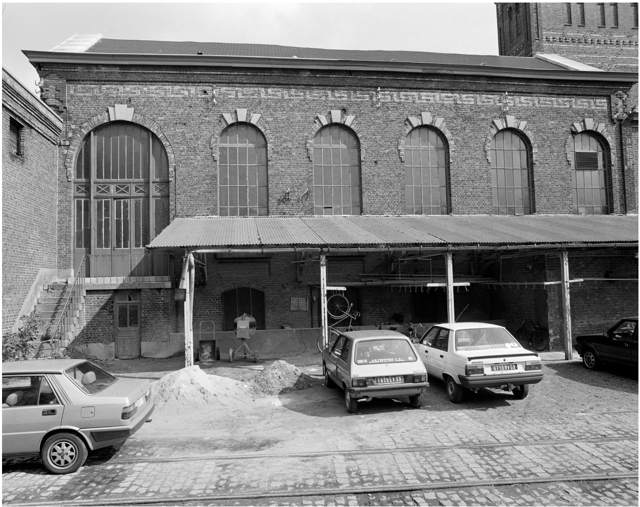
Salle des machines. Élévation sur cour.
