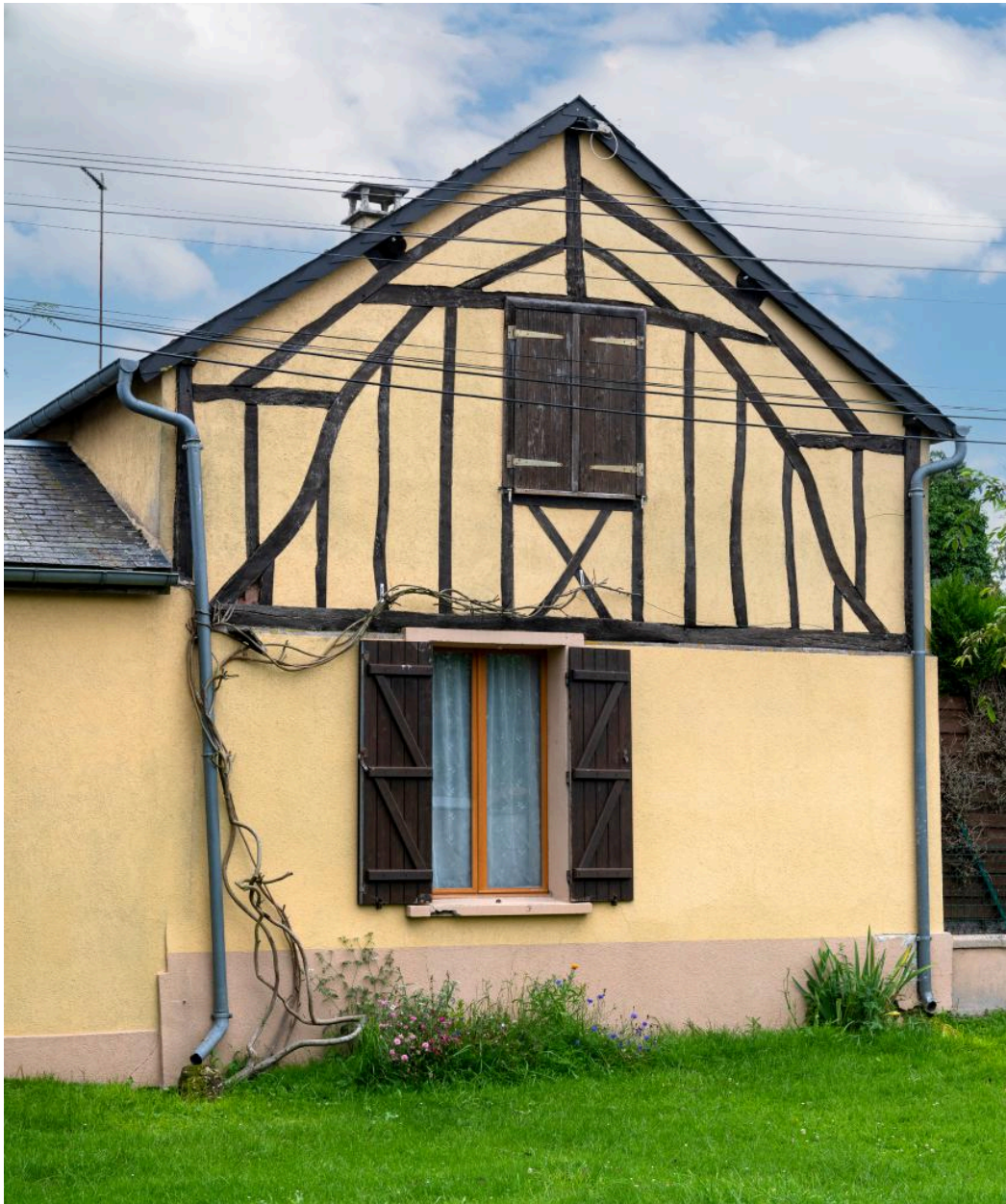
Pignon avec pans de bois apparents au n°52 rue Principale, vue depuis l'est.
