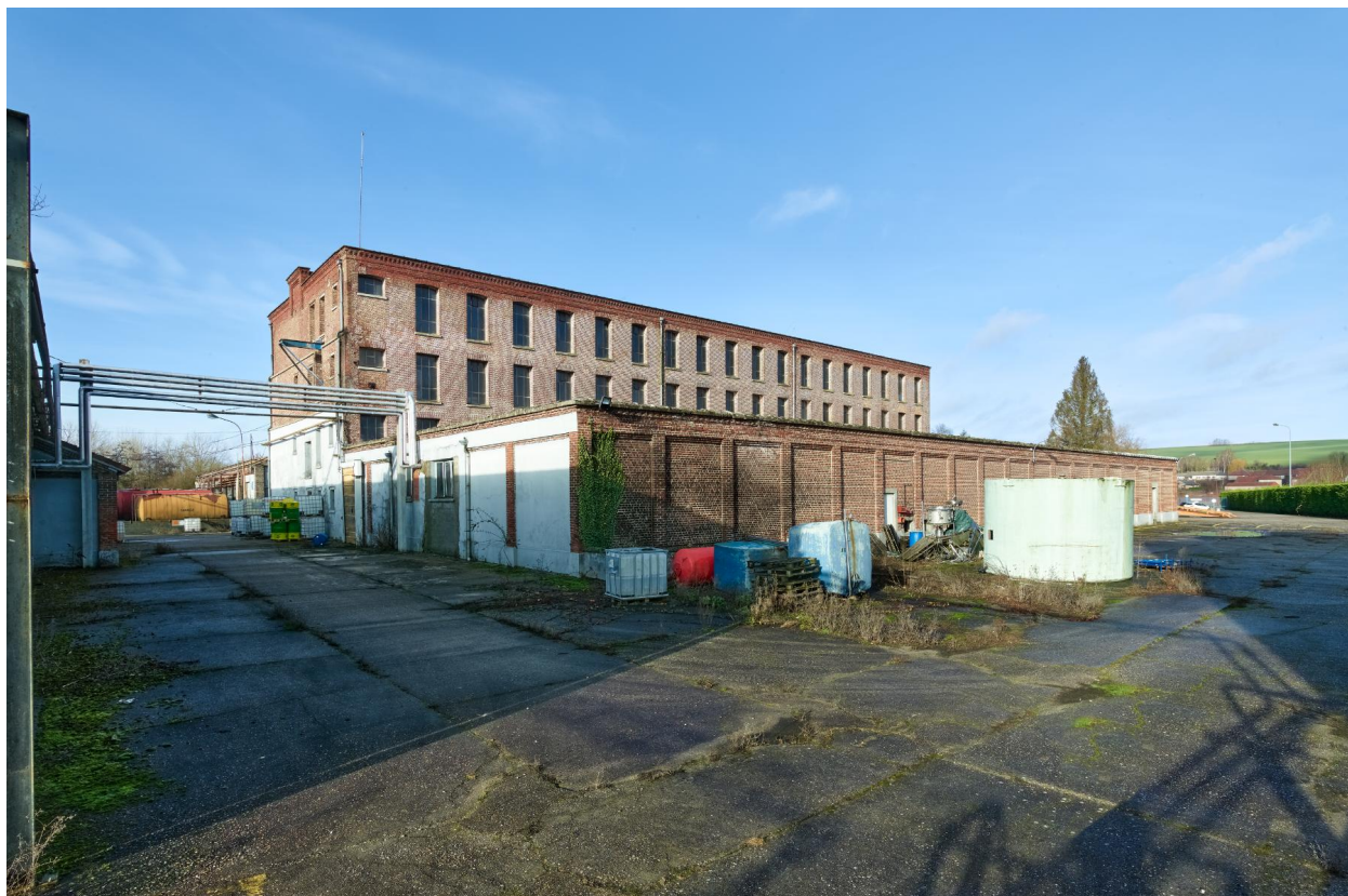
Bâtiment A, vue d'ensemble depuis le sud-est.
