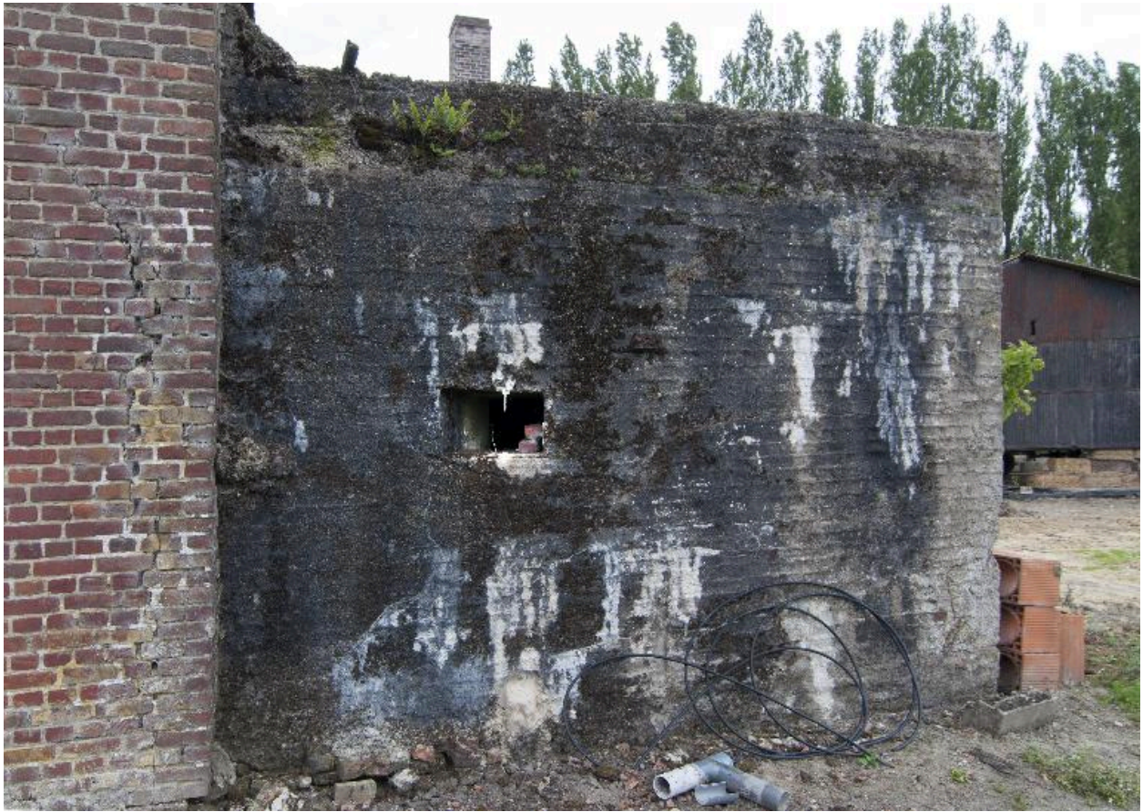
Casemate B, vers le sud-ouest
