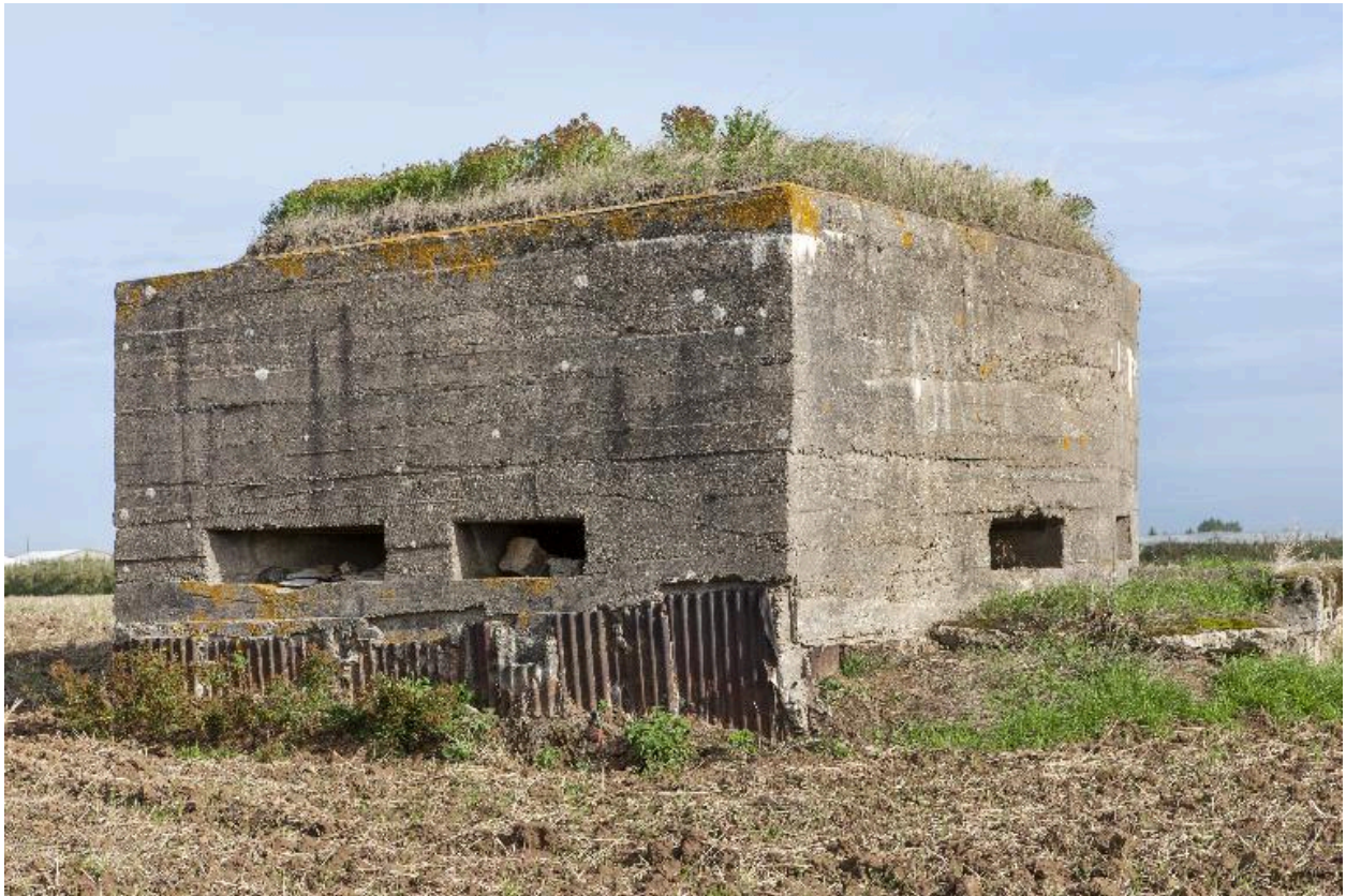
Vue de trois-quarts vers le nord-ouest
