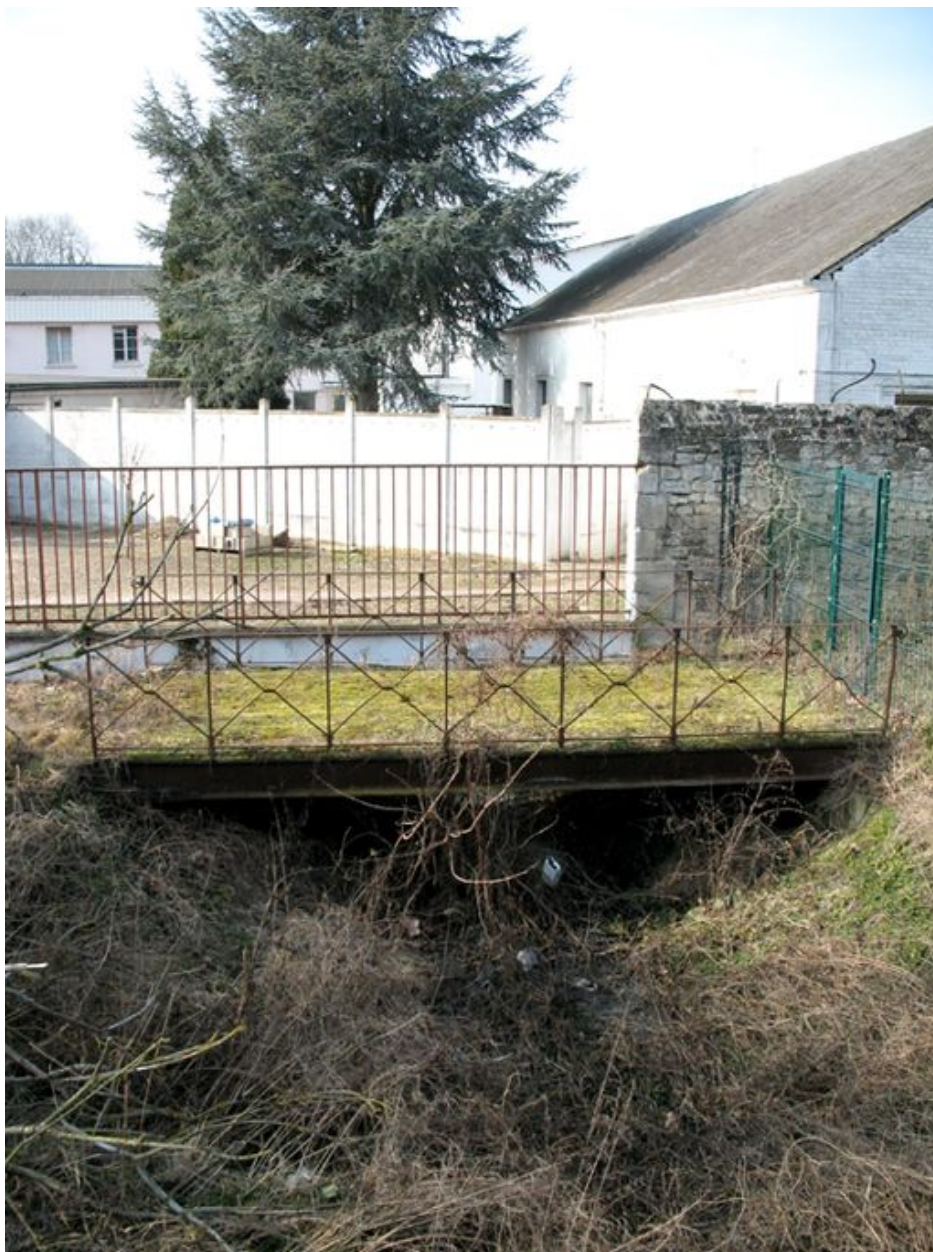
Pont sur la Brèche à l'entrée de l'usine, témoin du passage de la rivière au coeur du site.
