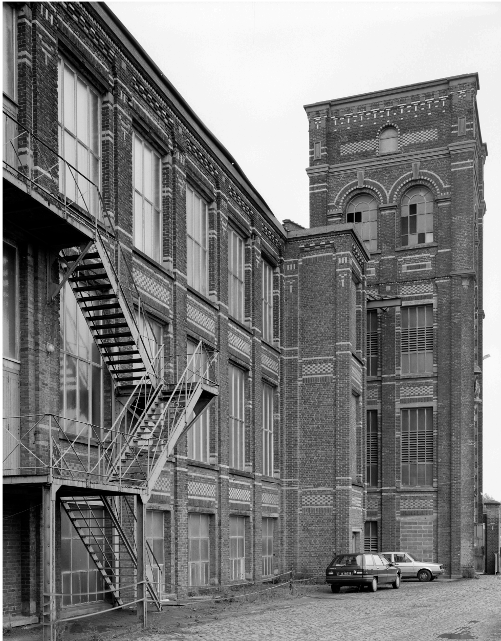
Atelier de fabrication et tour abritant l'escalier. Vue prise vers le sud-est.
