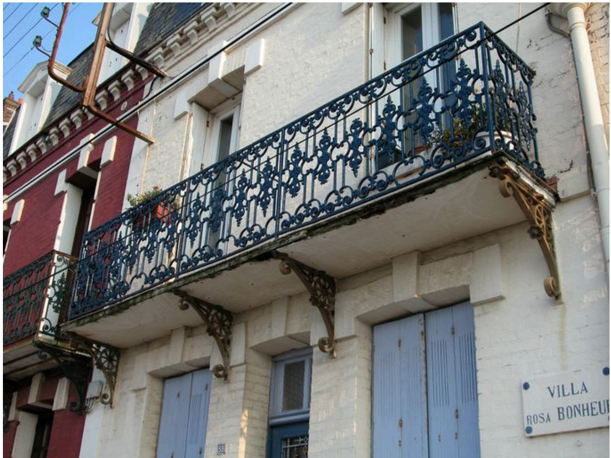
Détail d'un balcon en fonderie.
