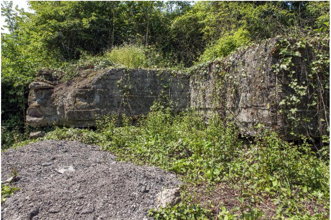
Vue générale, vers le nord-ouest
