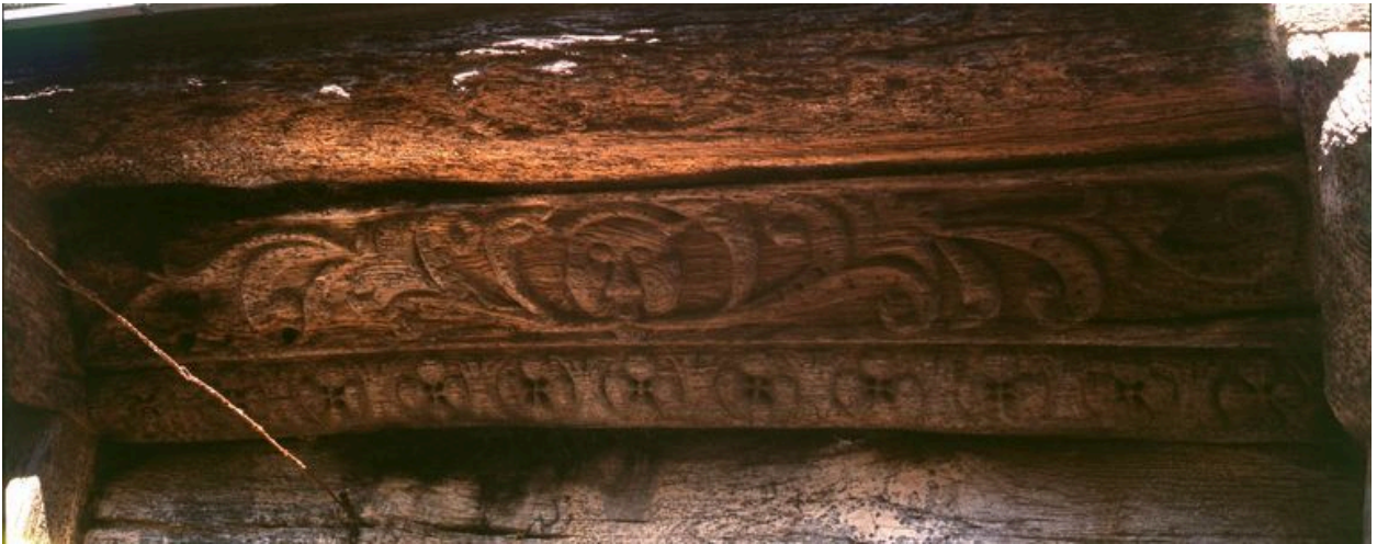
Détail d'une poutre sculptée de la maison Landot, élévation postérieure sur cour.
