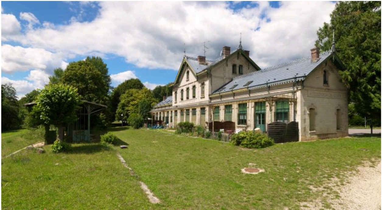
Emprise des voies, quais et bâtiment des voyageurs vus depuis l'est.
