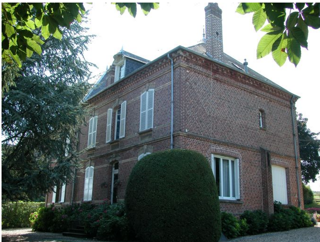
Ensemble sud-ouest de la maison patronale principale.
