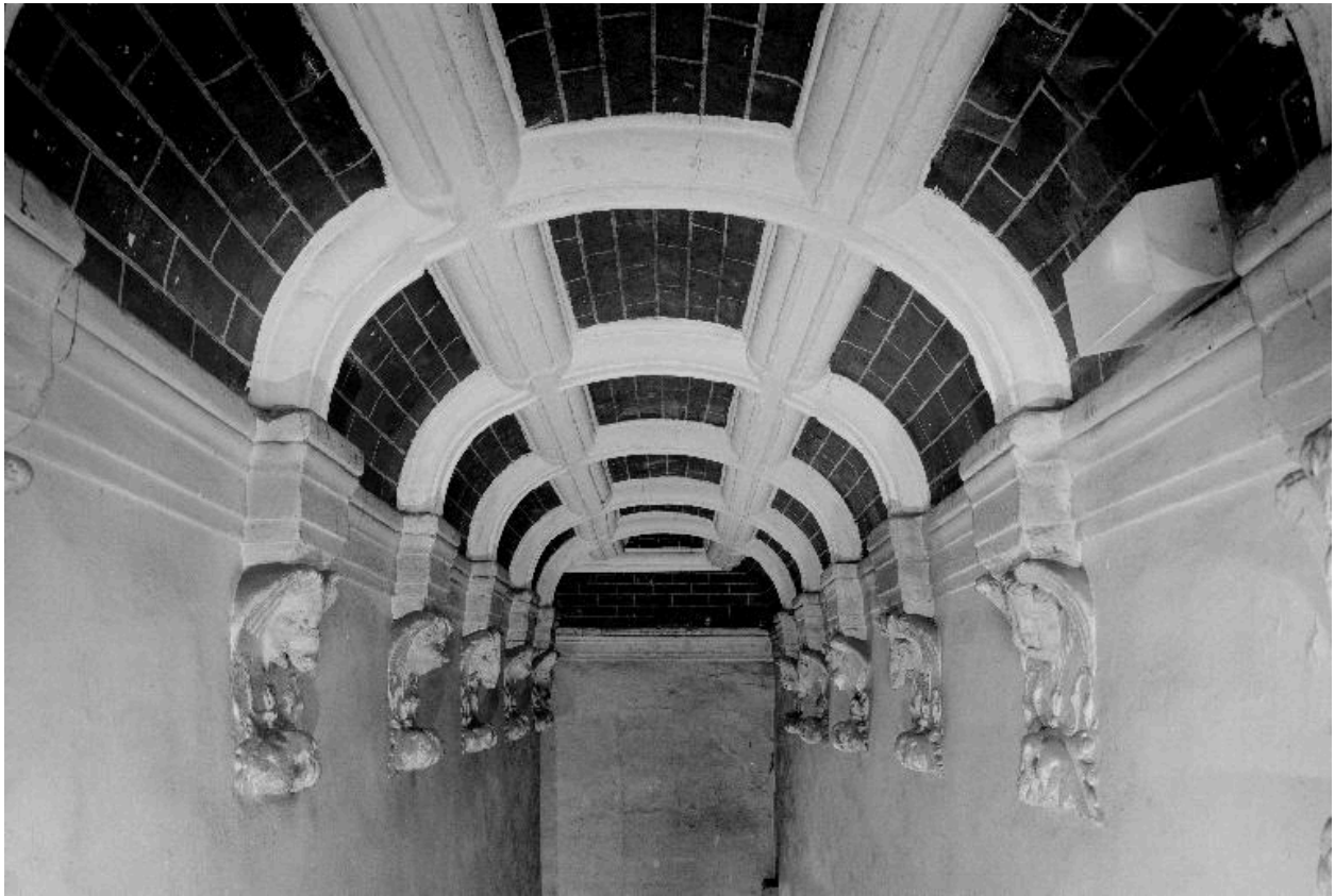
Escalier sud-est des offices : vue de la voûte de la deuxième volée.
