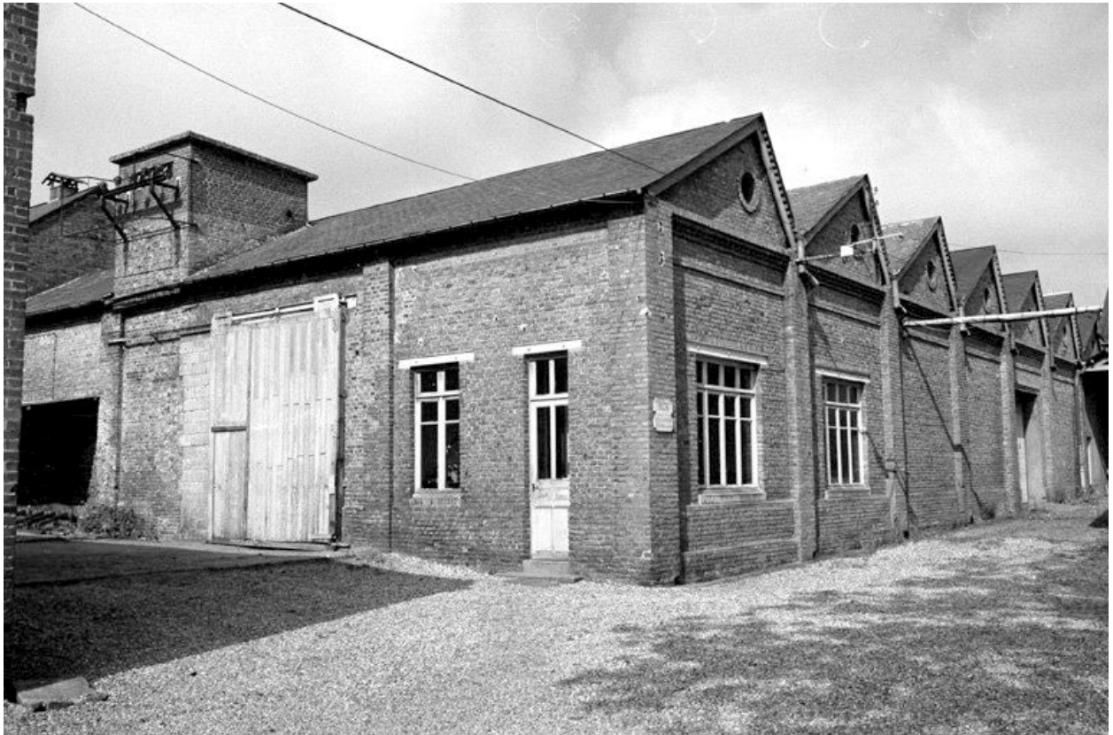
Atelier de fabrication, élévation antérieure.
