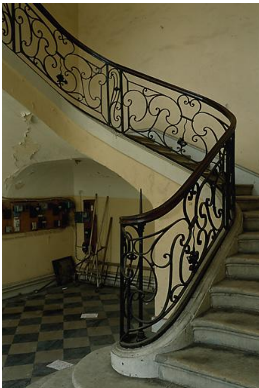
Escalier intérieur, rampe.
