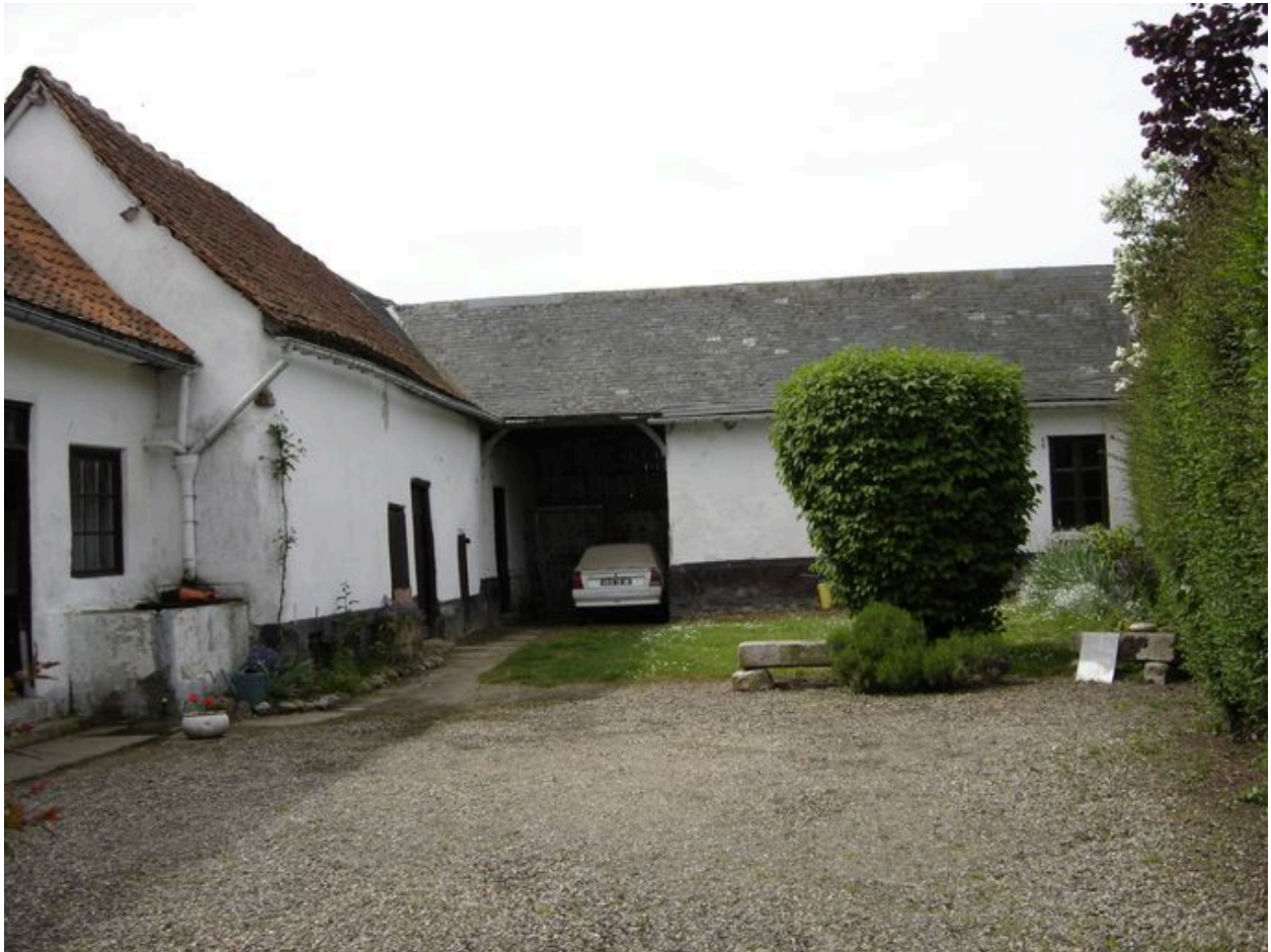
Vue du passage couvert et des étables situés au nord.
