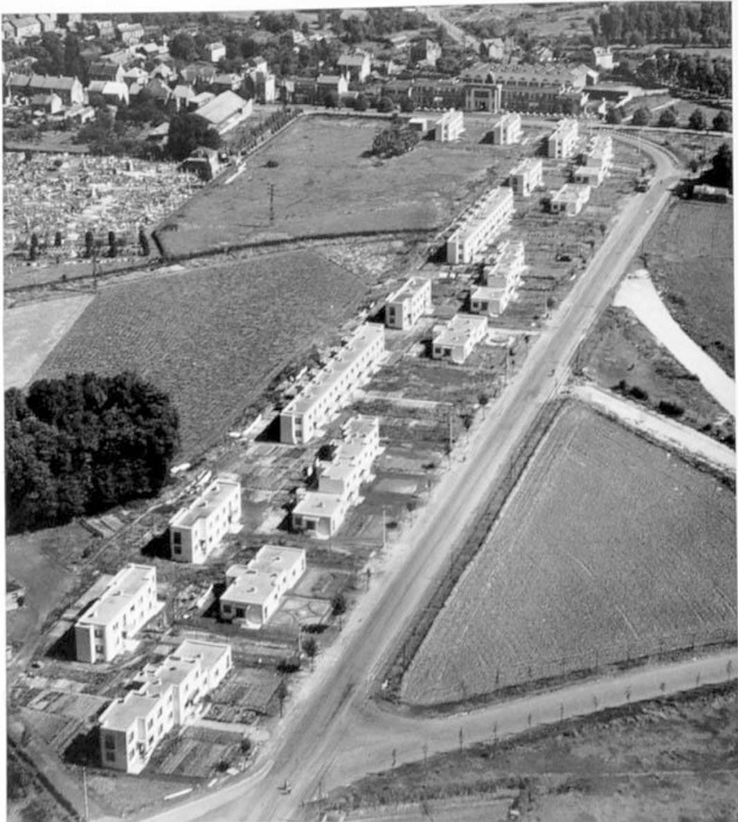
144. Reconstruction de Maubeuge, maisons individuelles, route de Valenciennes, 1947. Vue aérienne (la composition sur 2 épaisseurs).
