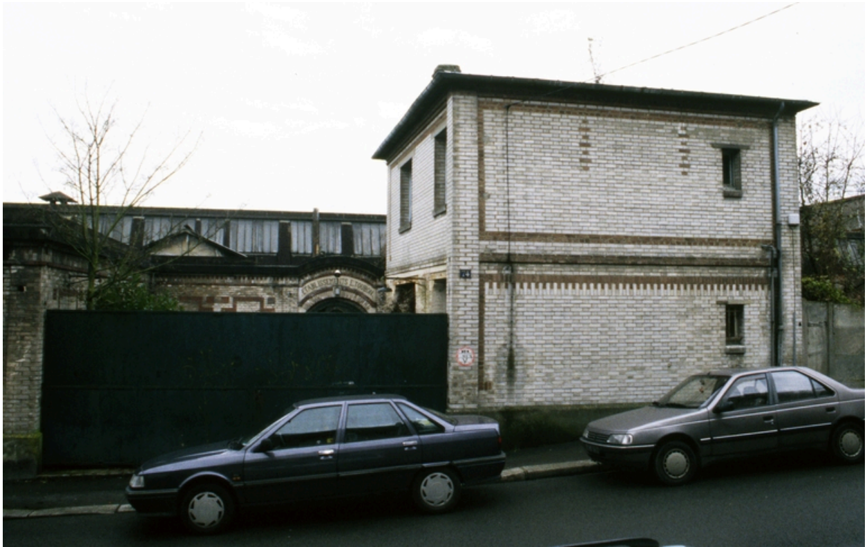
Entrée de l'usine réservée au personnel (rue Voltaire), 2001. A droite, la loge du concierge.
