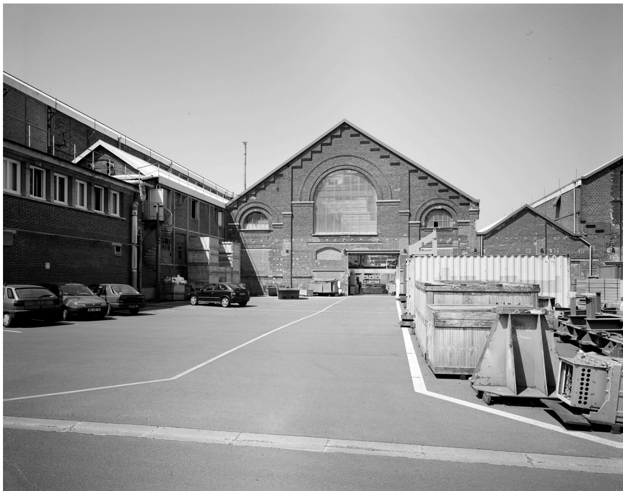
Élévation sud de la halle 7.
