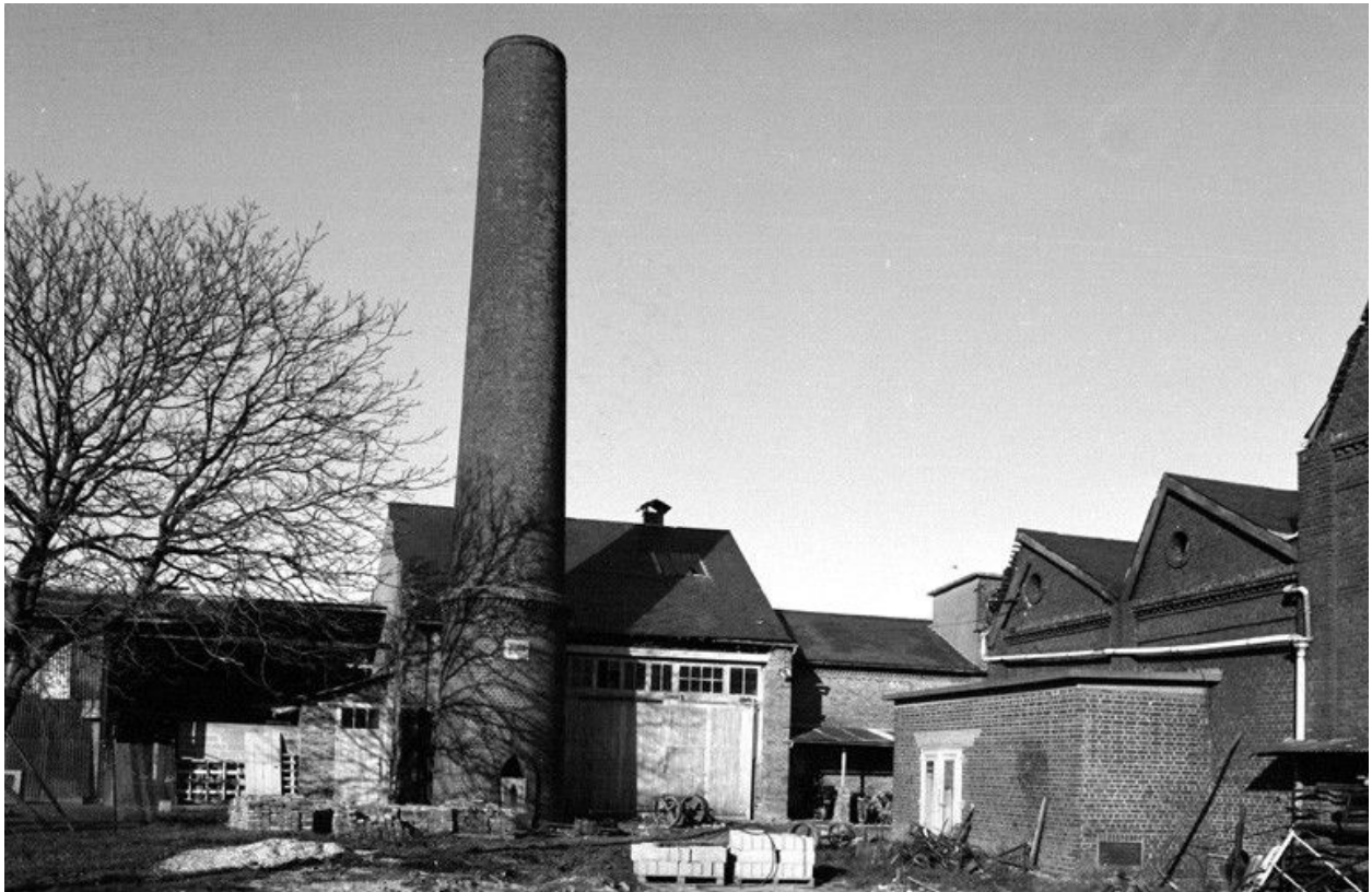
Vue partielle de l'usine, flanc sud.
