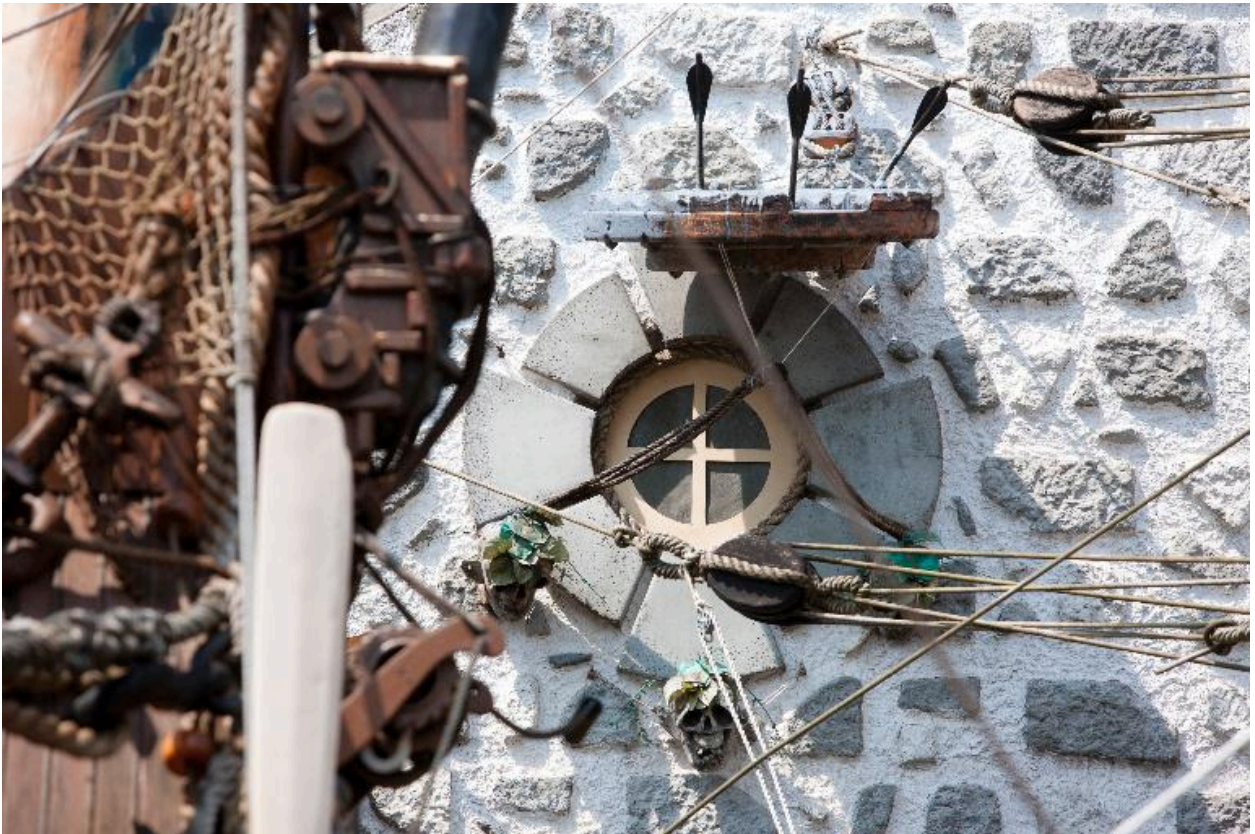
Vue partielle du pignon.
