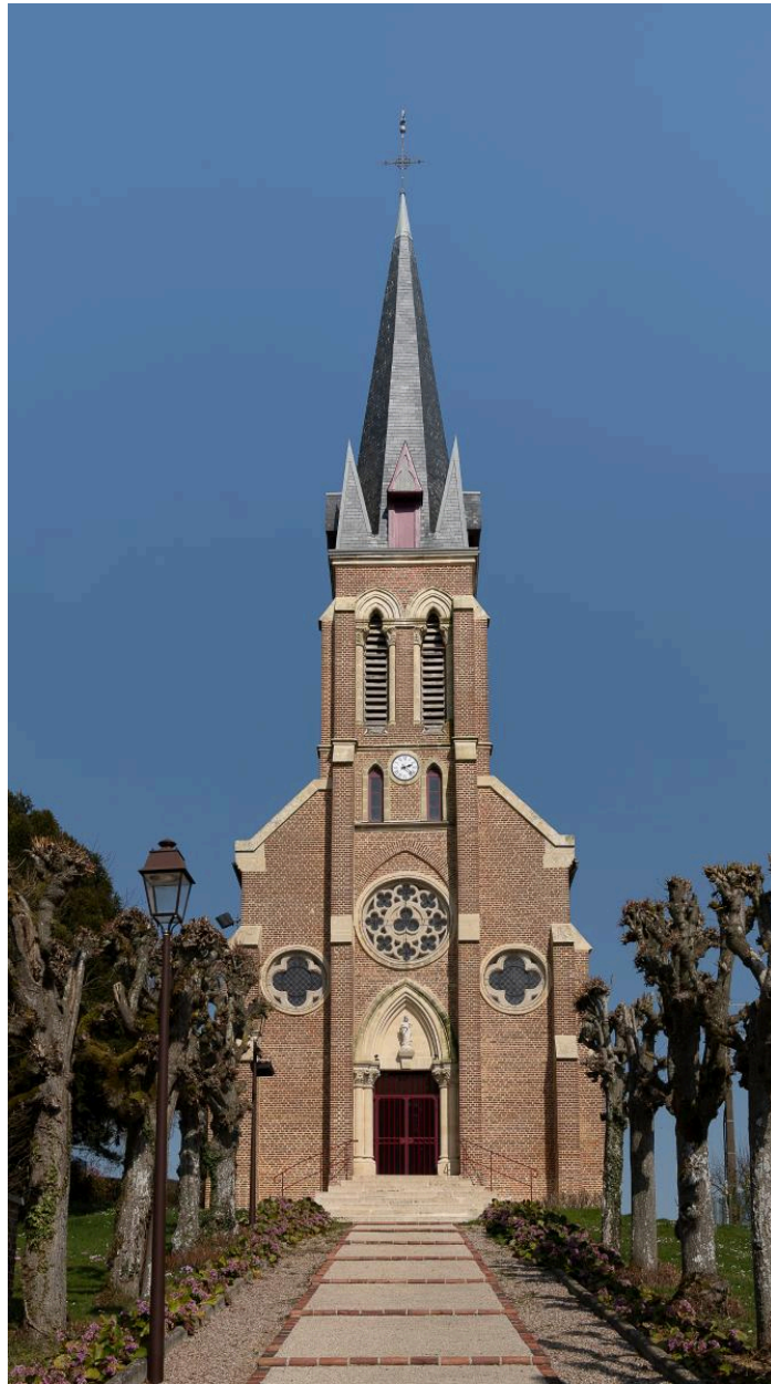
Vue générale de la façade occidentale.
