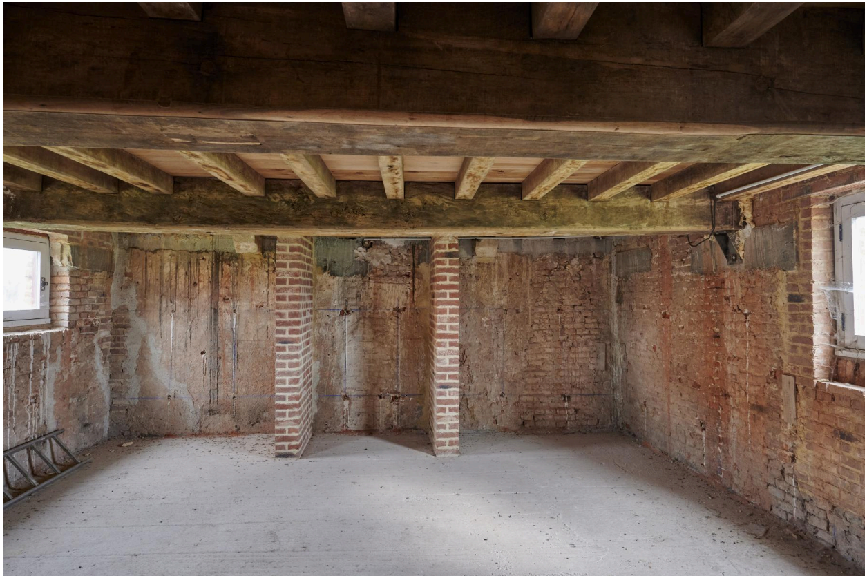
Rez-de-chaussée. Logis du XVIIe siècle. Arrière-cuisine.
