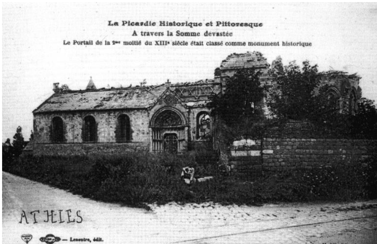
Le portail du 13e siècle, après 1916 (AD Somme ; DA 3030/44).
