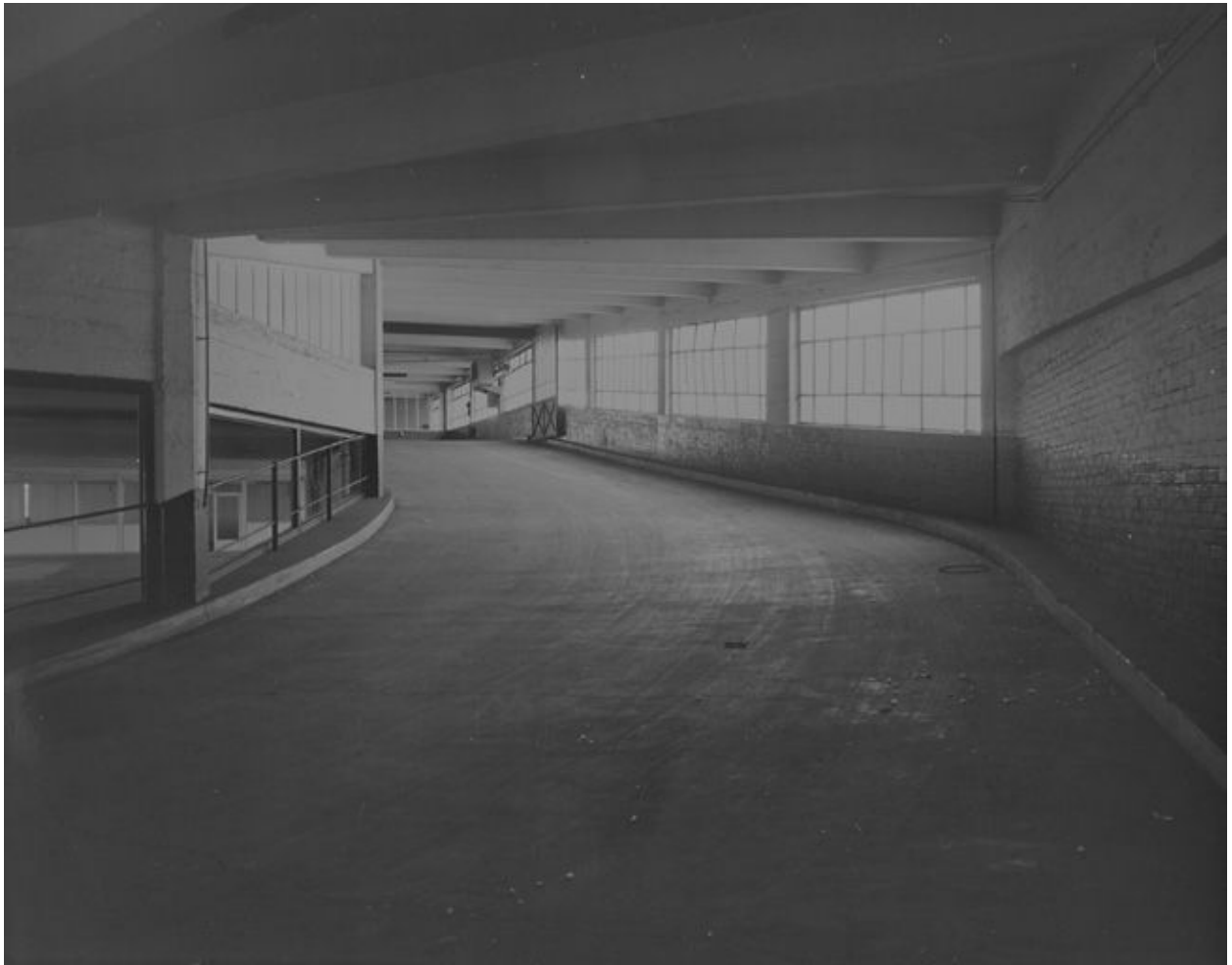
Vue d'ensemble de la rampe d'accès entre le niveau 2 et le niveau 3.
