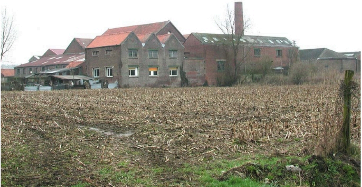
Vue générale arrière de l'usine.
