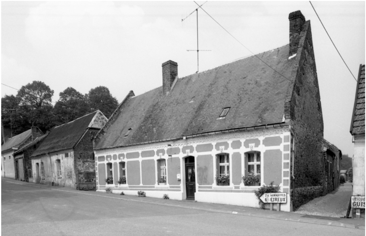
Vue d'ensemble du logis, depuis le sud.
