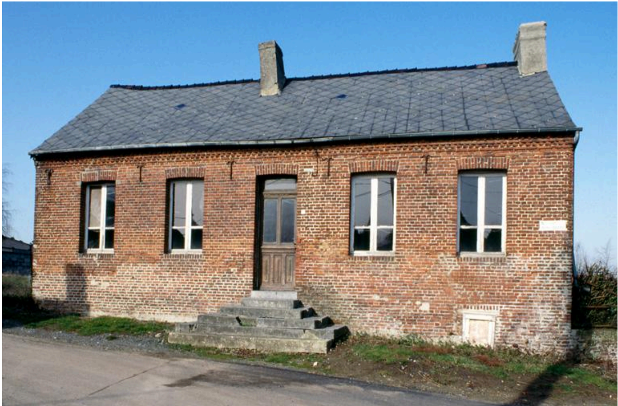
Vue d'ensemble de la façade.
