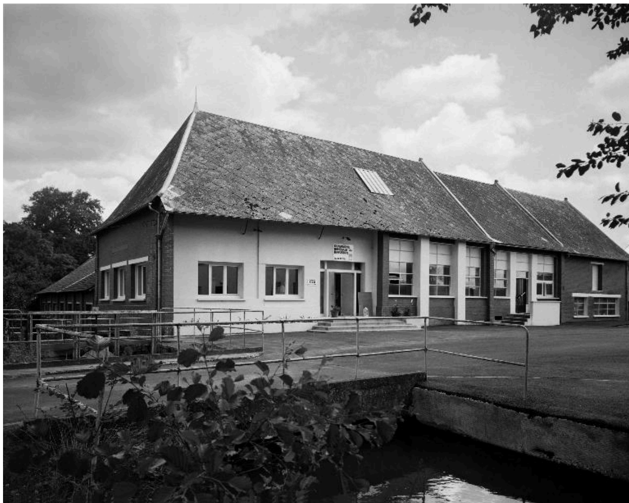
Bâtiment d'eau, atelier de fabrication.
