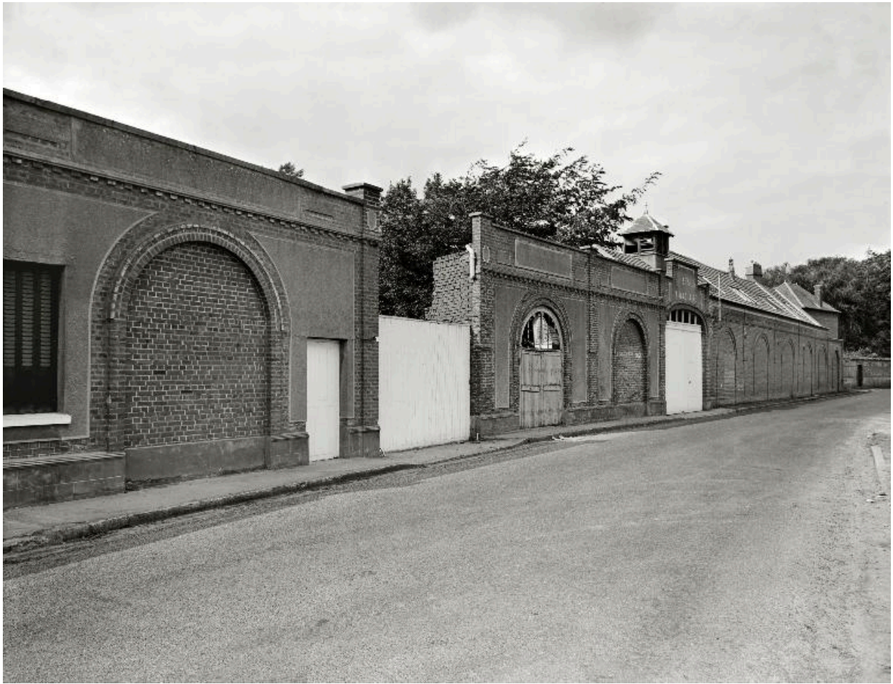
Vue générale des anciens établissements Maclaire, depuis la rue, en 1988.
