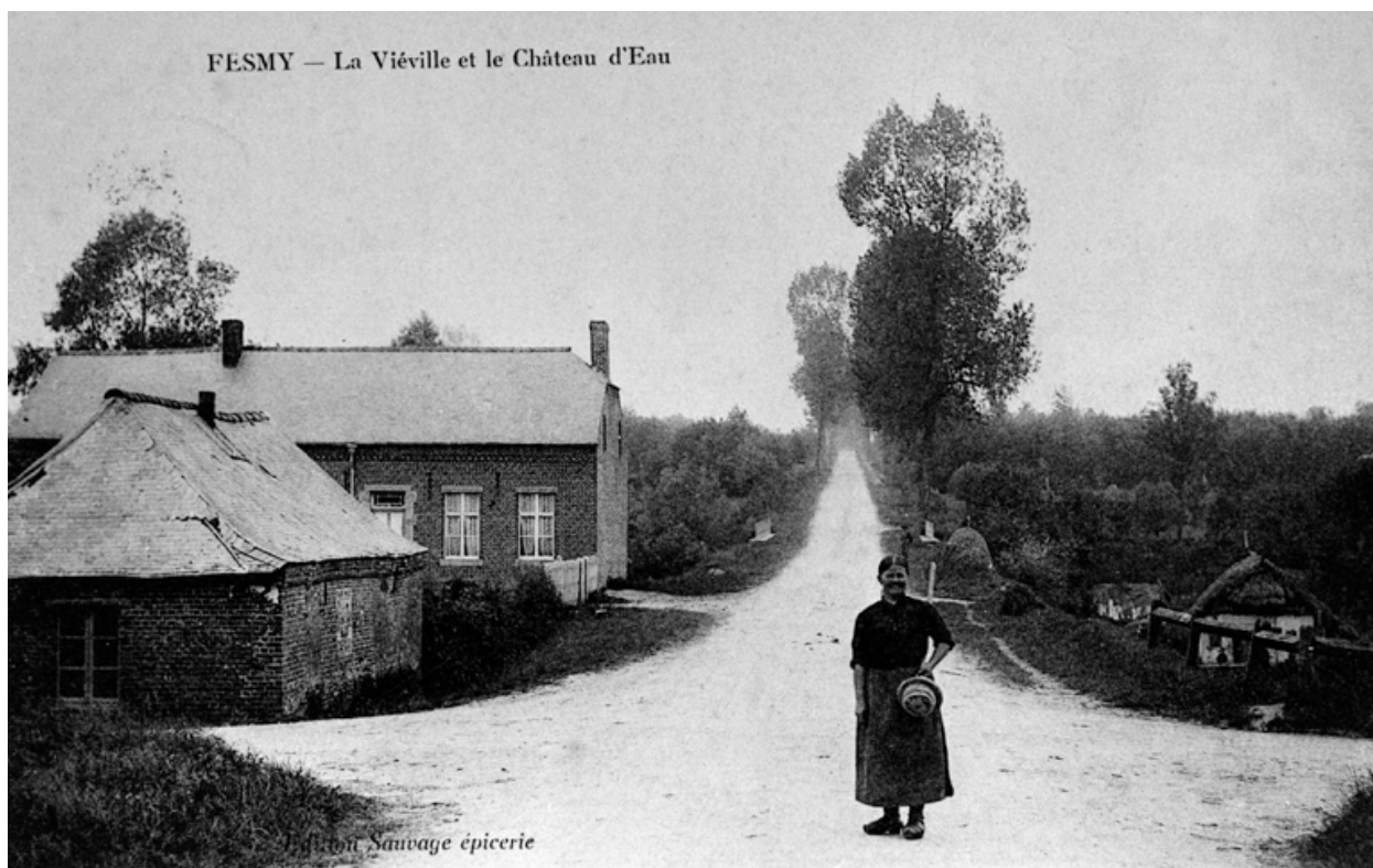
Ancienne route de Metz à Calais, vue du sud-est vers le nord-ouest, à l'endroit de son croisement avec la voie communale de Fesmy-au-Sart, avant 1914 (coll. part.).
