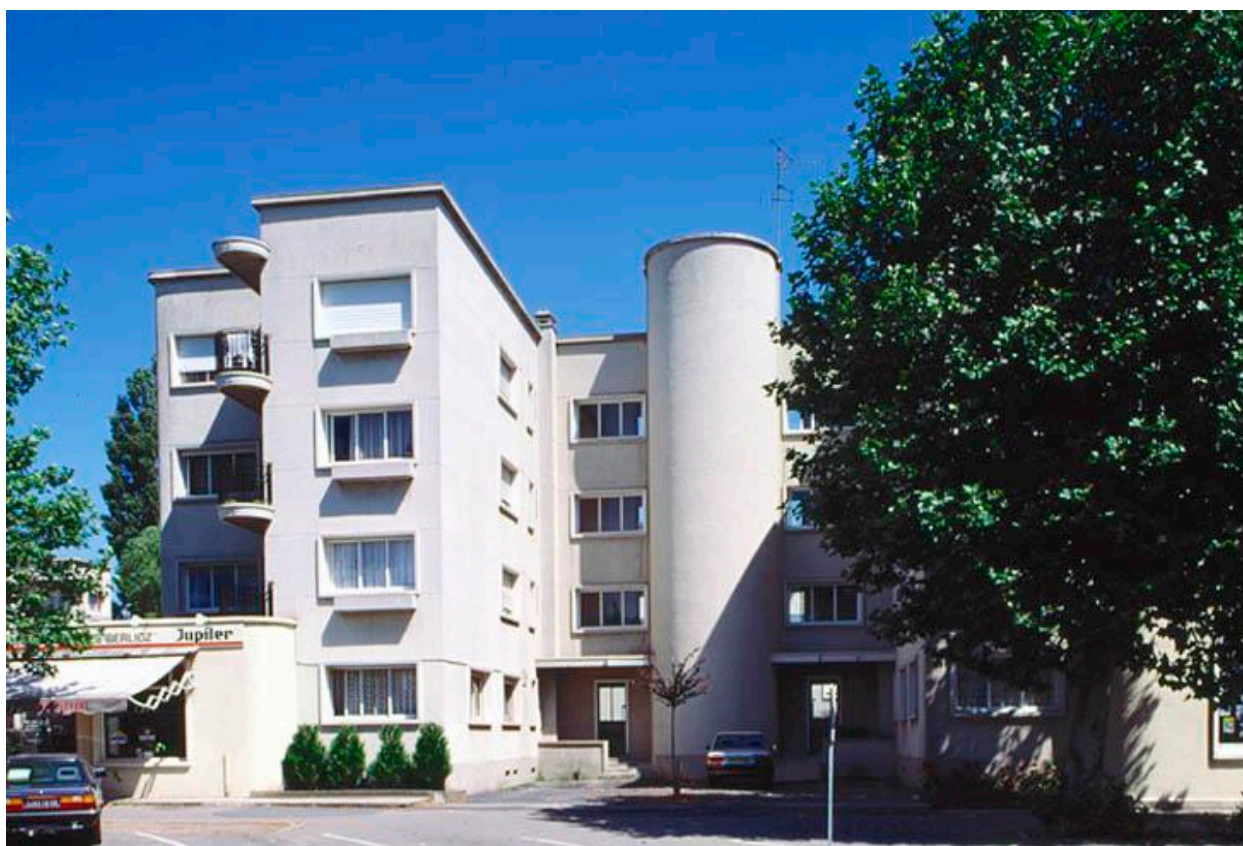
Élévation sud avenue de la gare, de l'immeuble en forme de H.
