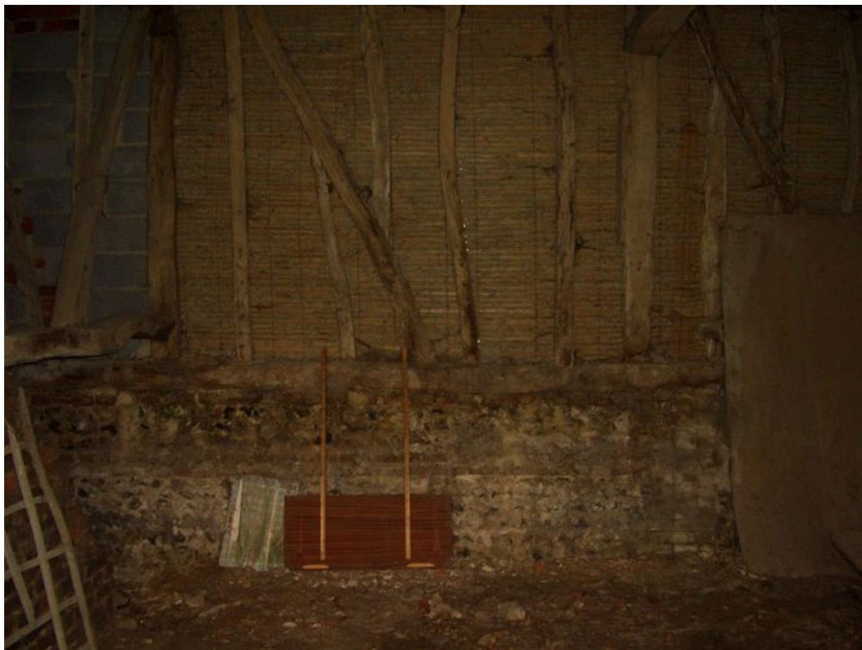
Vue intérieure de la grange.
