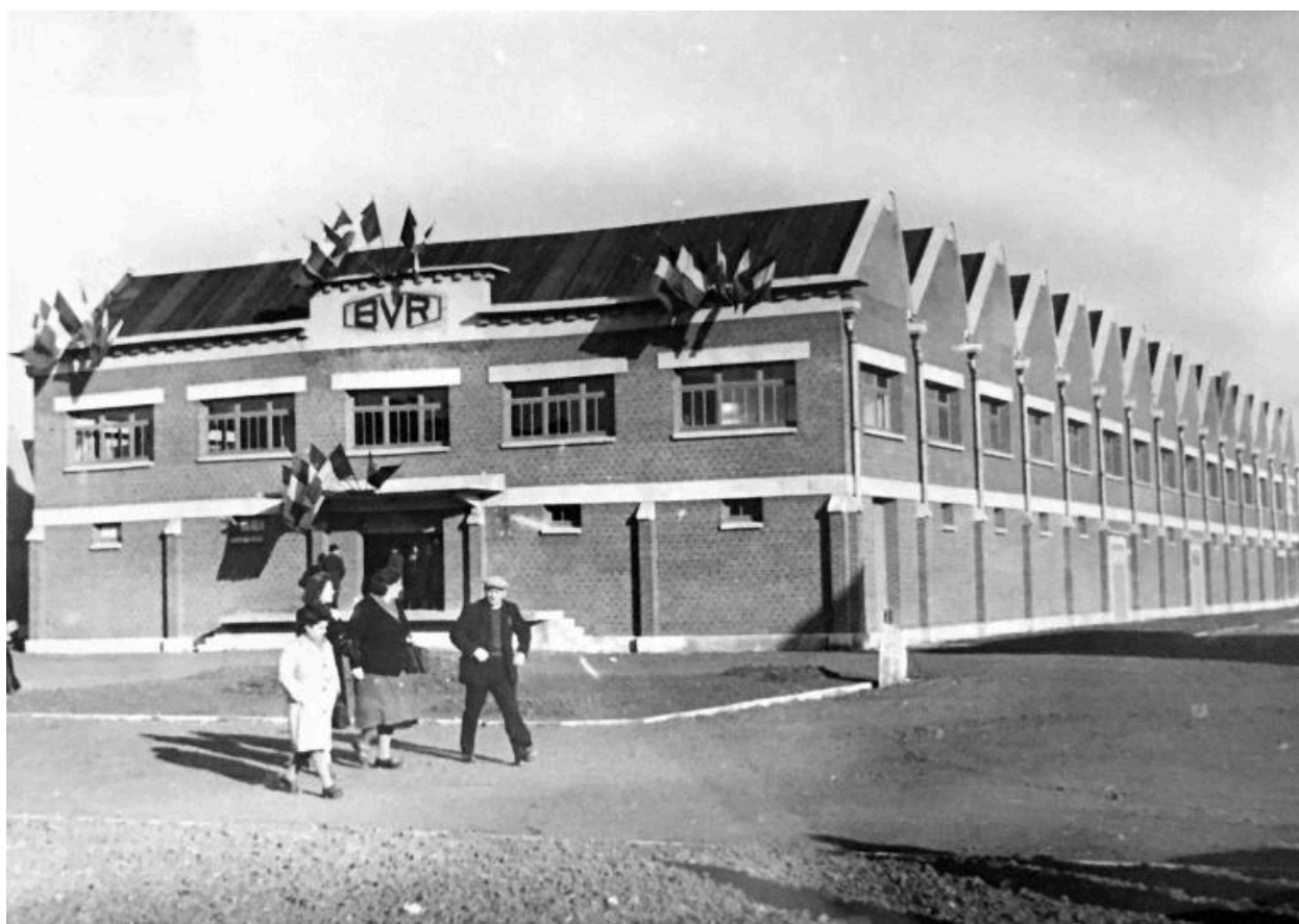
L'entrepôt aux matières premières et l'atelier de confection reconstruit, après juillet 1946 (coll. part.).
