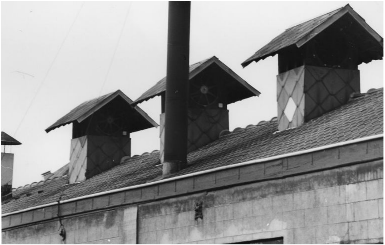
Les ateliers de teinture, détail des cheminées d'aération.
