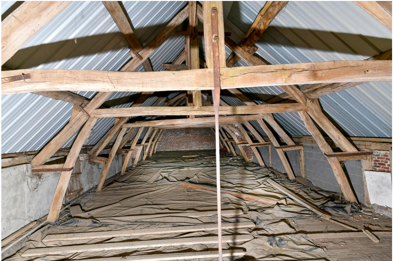
Charpente de l'étable à vaches.
