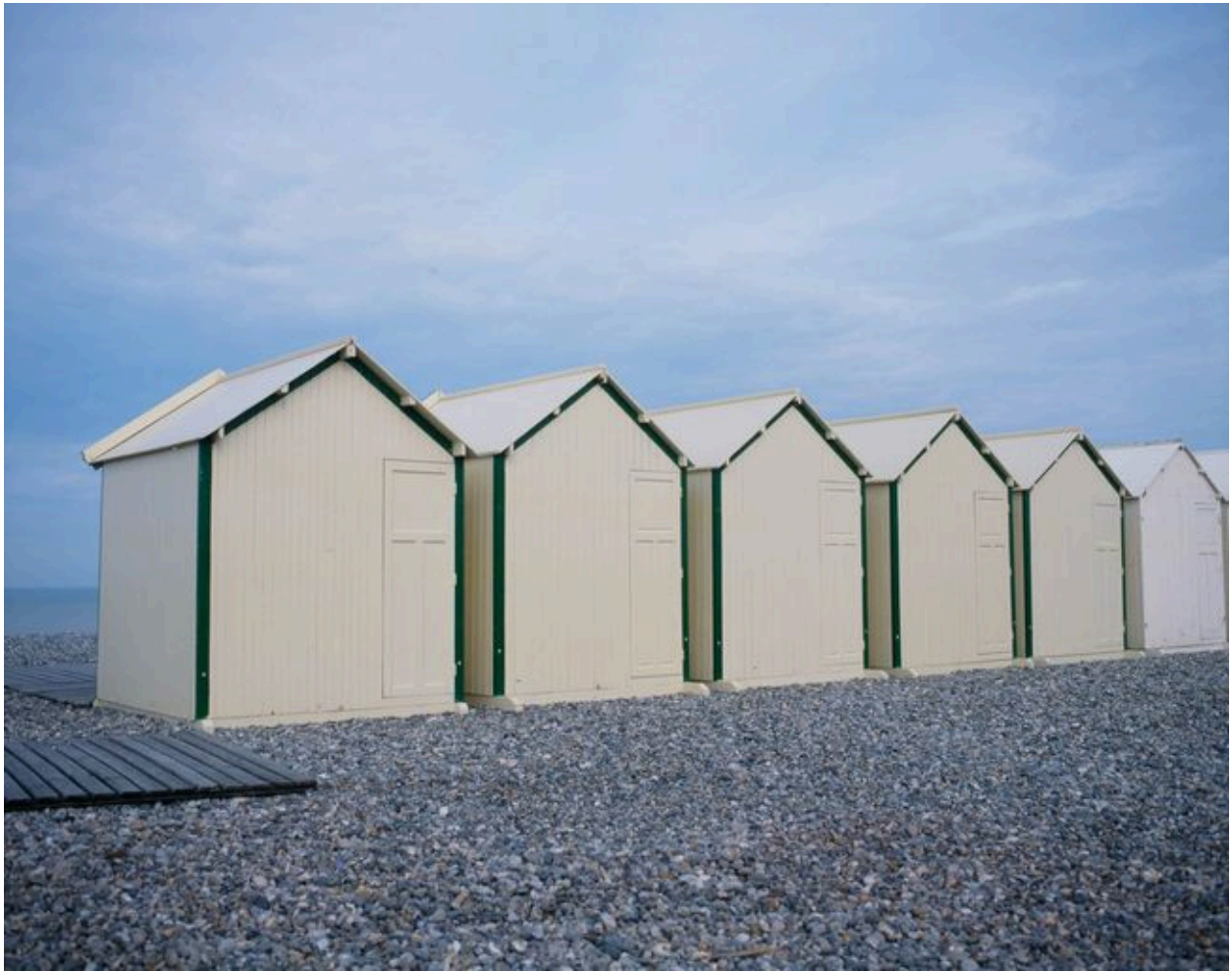
Ensemble de cabines, élévations postérieures.
