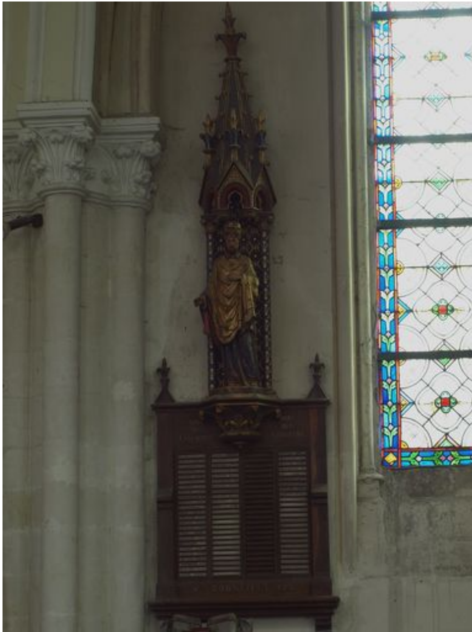
Sud : vue d'ensemble
