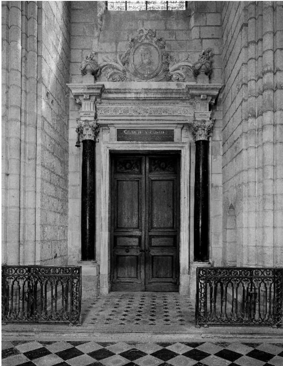
Vue générale de la porte.
